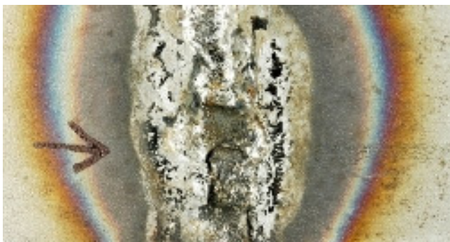
Abbildung 16 Verbliebene Anlauffarben im Inneren einer Klärschlammleitung [Foto: SLV Mannheim 2008]
