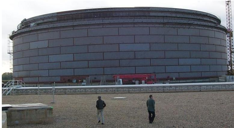
Das Tanklager besteht aus mehreren Tanks mit je 125.000 m<sup>3</sup> Fassungsvermögen. Die Tanks haben einen Durchmesser von ca. 85 m und eine Höhe von ca. 24 m. Sie sind aus Stahlblechen mit einer Breite von ca. 2,5 bis 3,0 m und einer Länge von 10 bis 12 m gefertigt. Die Blechdicken betragen 10 bis 40 mm für den Mantel und 6 bzw. 8 mm für den Tankboden. Als Stahlgüten werden S235 und S355 eingesetzt.
