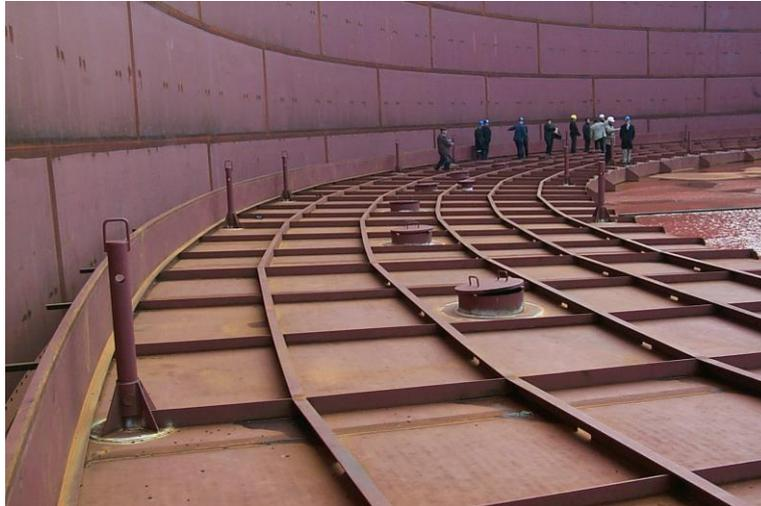
Bei Tanks dieser Größe ist ein festes Gespärredach nicht mehr wirtschaftlich. Es wird ein Schwimmdach ausgeführt. Das Schwimmdach besteht aus einem ringförmigen Ponton, der entlang der Tankwand auf dem gelagerten Medium schwimmt, und einer Blechmembran (ca. 5 mm dick !), die ebenfalls auf dem Medium schwimmt. Im Bauzustand liegen der Ponton und die Membran auf einem Raster von ca. 2 m hohen Stützen, so daß man auch von unten schweißen kann.
