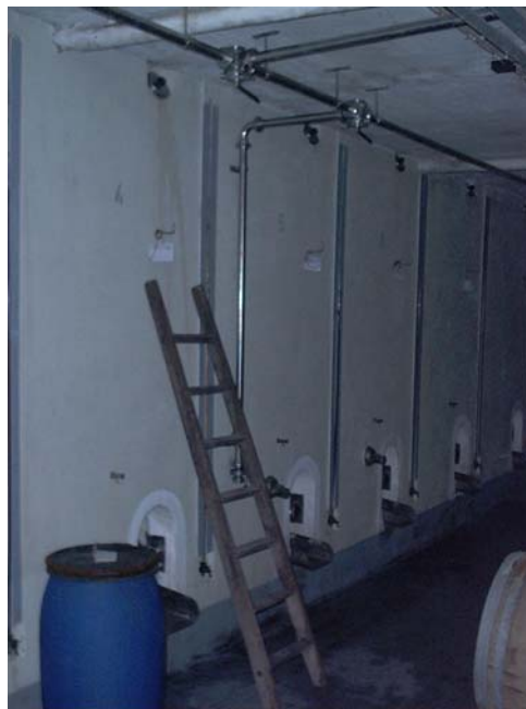
Bild 5: Mehrkammer-Betonbehälter, mit Glas- platten ausgekleidet, je 5000 bis 10000 Liter
